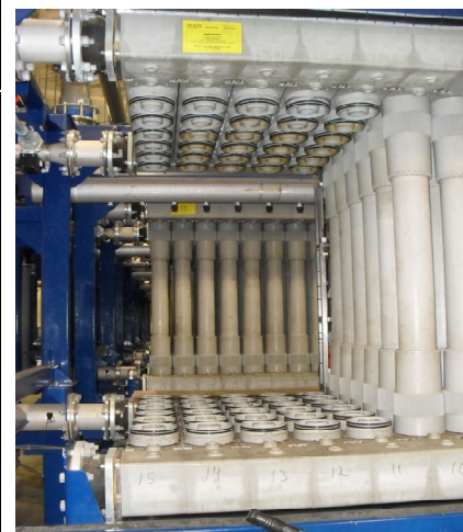
Membrane Module Replacement
