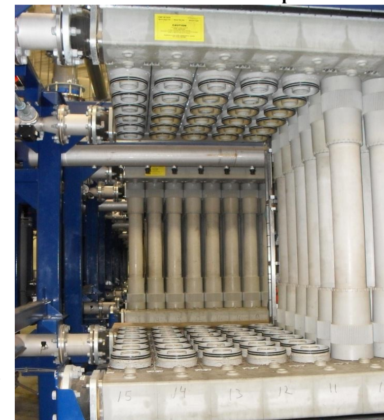
Membrane Module Replacement
