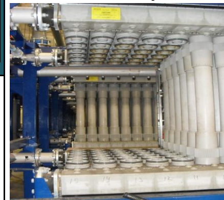
Membrane Module Replacement
