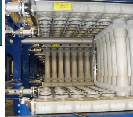
Membrane Module Replacement
